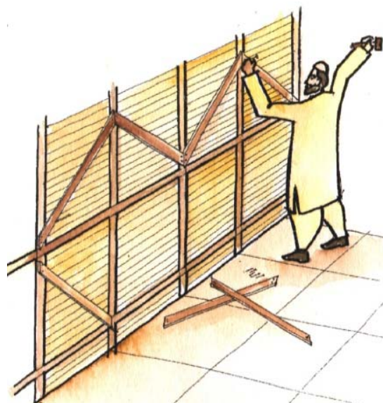
شکل ۹-۳۸ پیوستگی اعضای قطری
