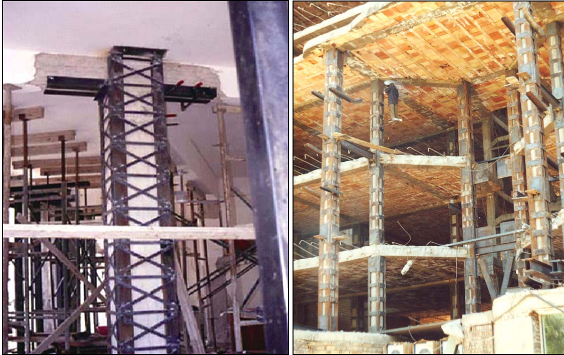
شکل ۲-۵-۱۳- بهسازی ستونهای بتنی بوسیله روکش فولادی قفسه‌ای
