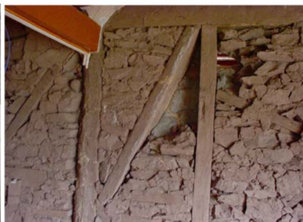
پ: ریزش تکه‌هایی از مواد پرکننده
