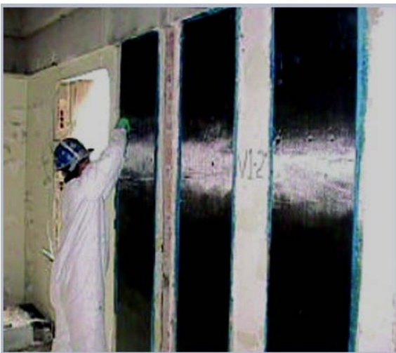
شکل ۸-۱۹ - نحوه اجرا و نصب نوارهای FRP
