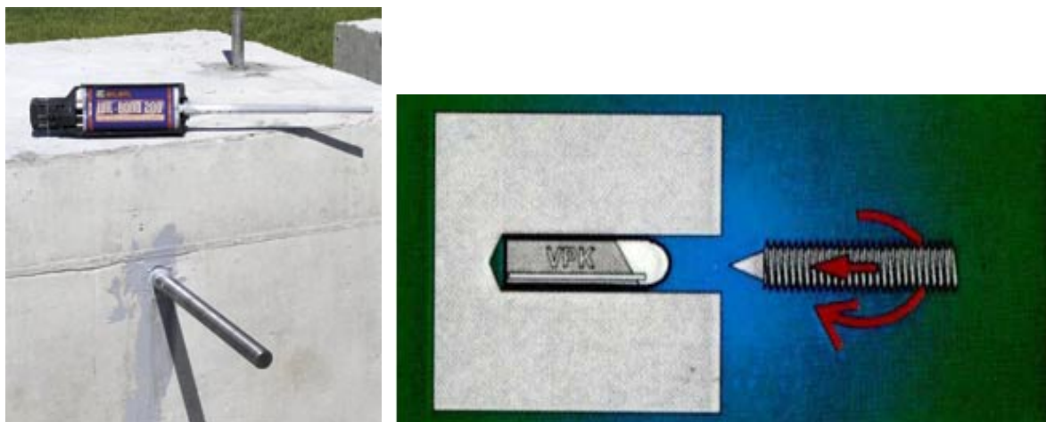
شکل ۲-۱-۲- کاشت پیچ به کمک مواد اپوکسی داخل کپسول
