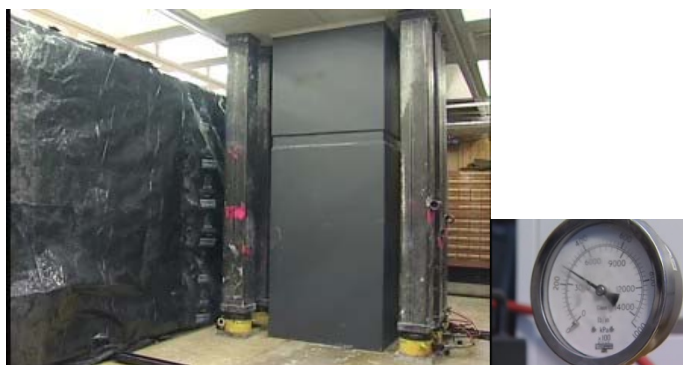
شکل ۶-۱۵- نصب جک‌های هیدرولیکی اطراف ستون جداشده
