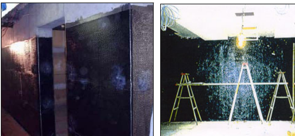
شکل ۴-۴۲- تقویت کلی دیوارهای برشی بوسیله مصالح FRP
