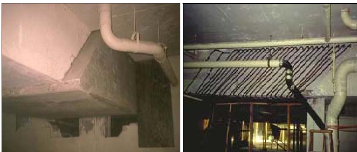
شکل ۲-۴-۴- استفاده از روکش بتنی در مقاوم‌سازی تیرها
