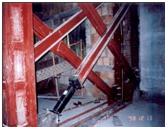
شکل ۷-۱۹- استفاده از میراگرهای ویسکوز در بادبندهای قطری
