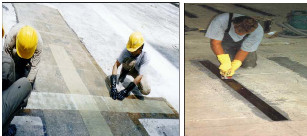
شکل ۱۱-۳-۲- مقاوم‌سازی دال در لنگرهای منفی بوسیله FRP
