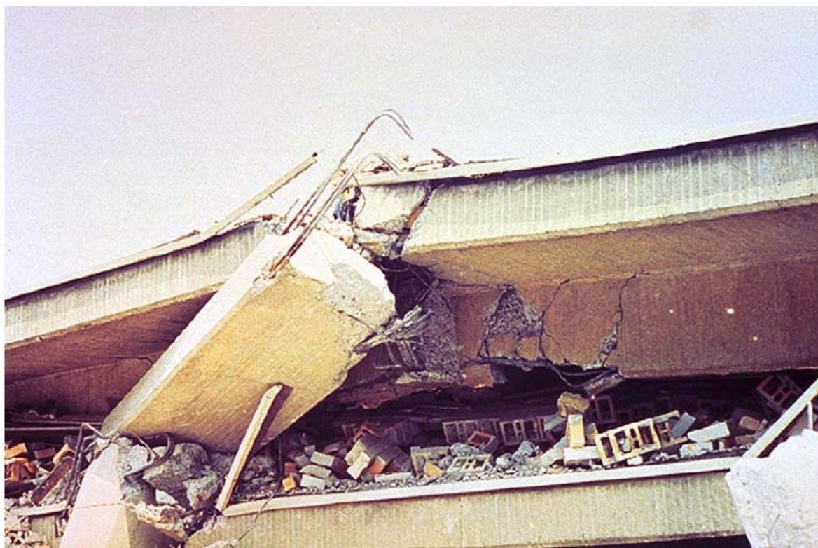
شکل ۲-۶-۱۰ وجود درز سرد در محل اتصال
