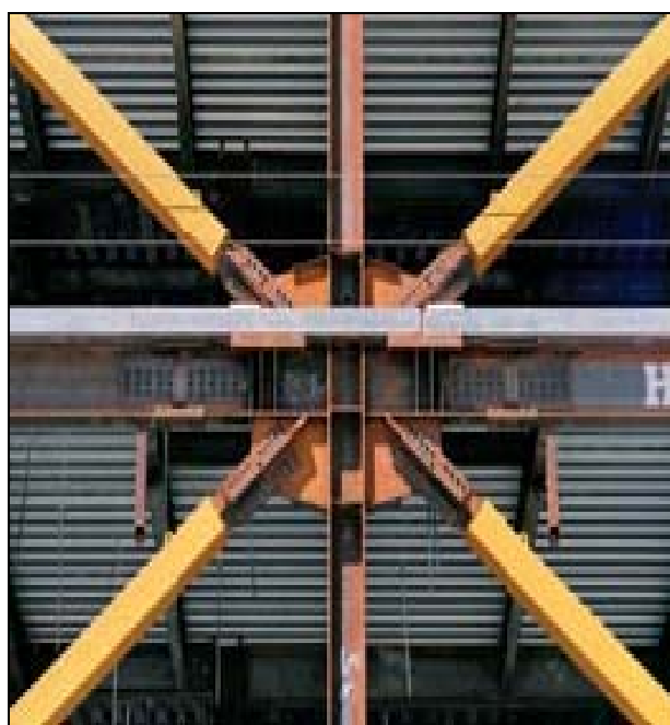
شکل ۴-۱۹- نمونه‌هایی از مه‌اربند ضد کمانش BRBF
