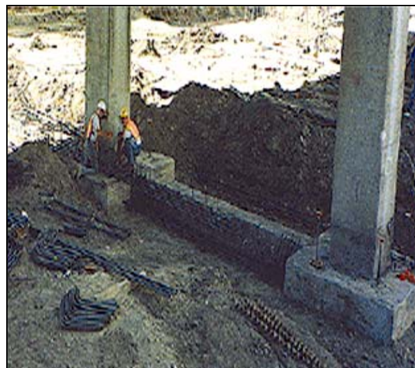
شکل ۴-۲-۲- به هم بستن شالوده‌ها با شناژ
