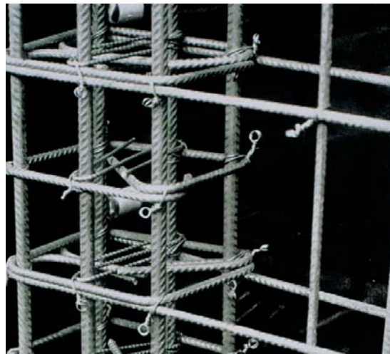
شکل ۳-۱۶- اجرای جزئیات مناسب و شکل‌پذیر در ستون‌ها
