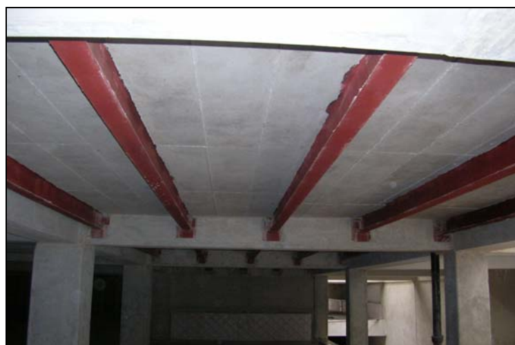
شکل ۲-۳-۵- اضافه کردن تیرک فولادی
