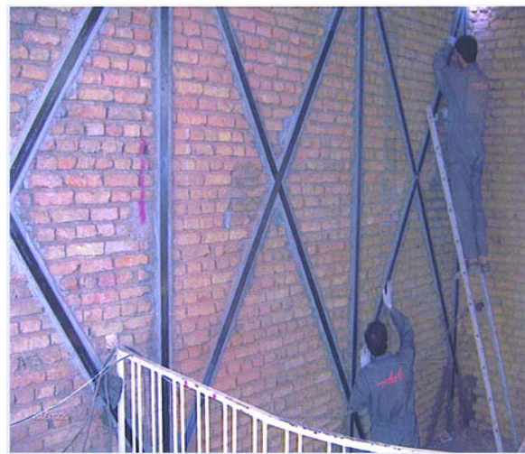
شکل ۸-۱۹ - نحوه اجرا و نصب نوارهای FRP
