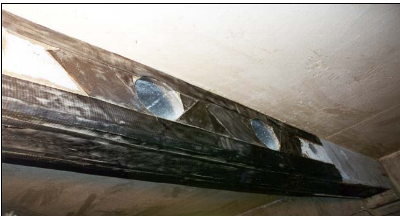
شکل ۲-۴-۱۵- تقویت موضعی سوارخ‌ها در تیر FRP
