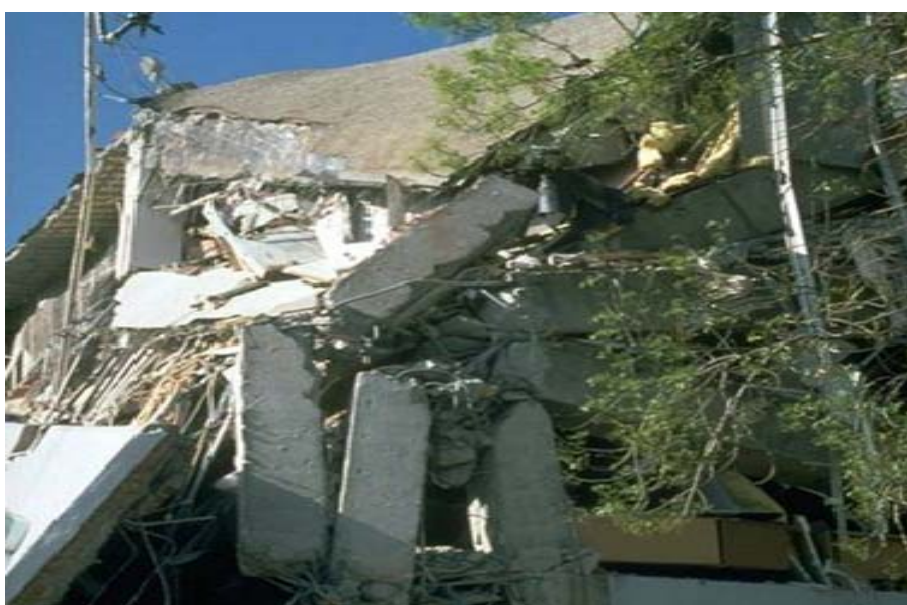
شکل ۲-۶-۵ نمونه‌هایی از شکست در اتصالات ضعیف بتنی
