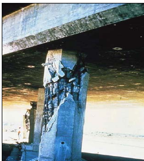
شکل ۲-۵-۱- نمونه‌ای از شکست برشی ستون
