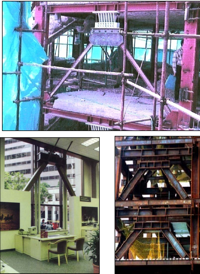
شکل ۷-۱۳- نمونه هایی از بکارگیری میراگر T-ADAS
