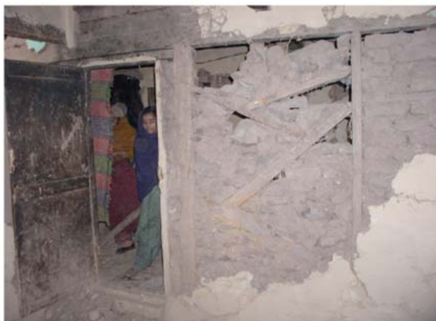
پ: ریزش تکه‌هایی از مواد پرکننده
