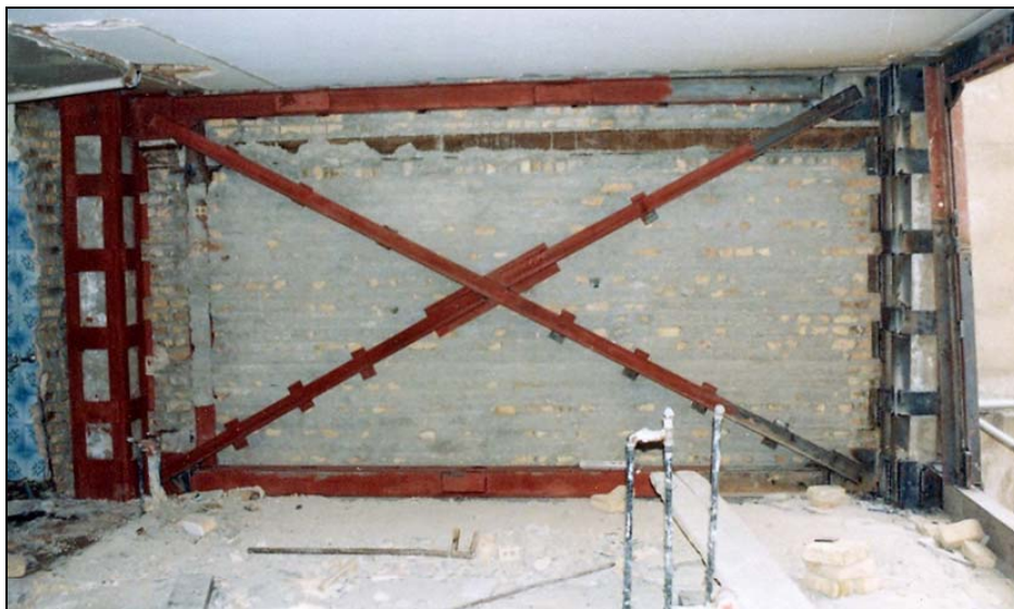
شکل ۴-۵- بهسازی قاب‌های موجود بوسیله مهاربندهای همگرا
