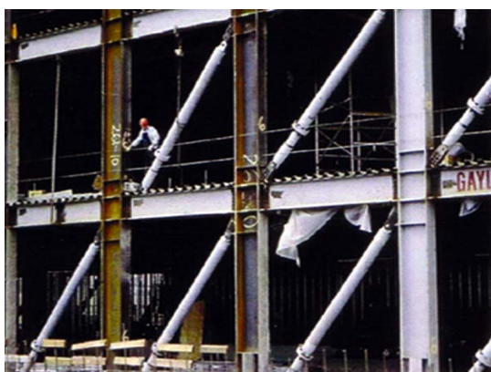
شکل ۷-۱۹- استفاده از میراگرهای ویسکوز در بادبندهای قطری
