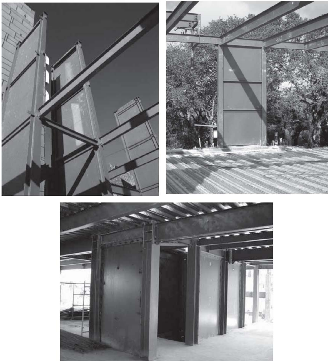
شکل ۴-۵۰- دیوار برشی فلزی
