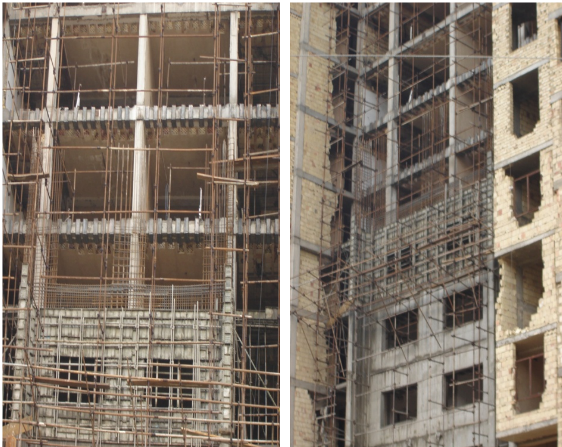
شکل ۴-۴۷ - افزودن میانقاب بتنی به عنوان دیوار برشی
