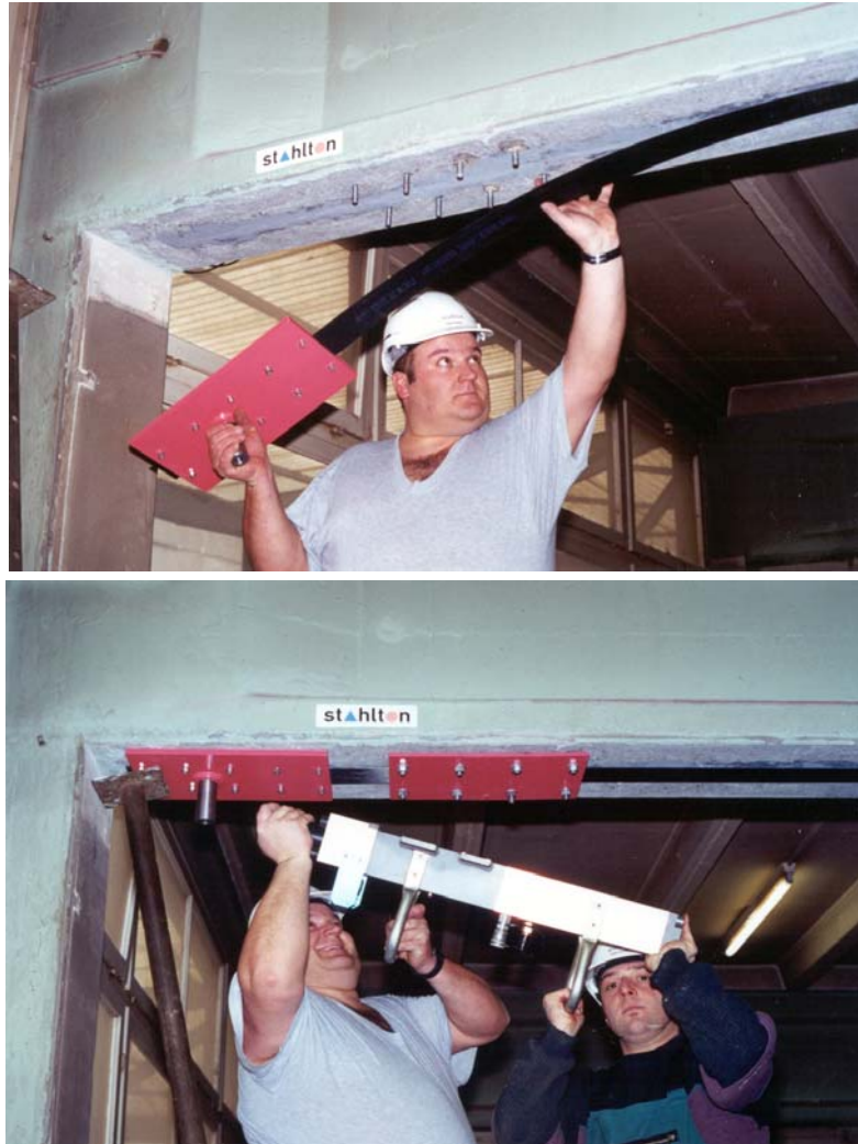
شکل ۲-۴-۱۷- روش پیش‌تنیدگی در صفحه FRP
