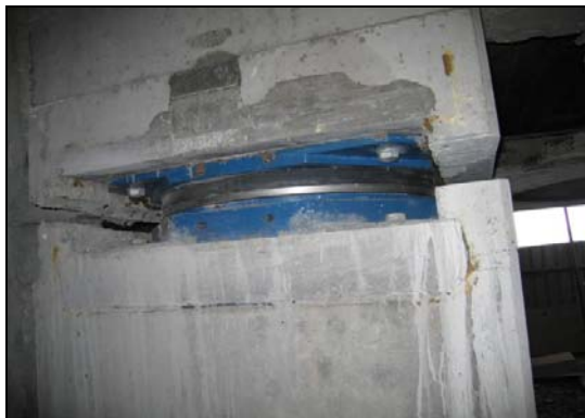
شکل ۶-۱۱- جداگرهای اصطکاکی FPS
