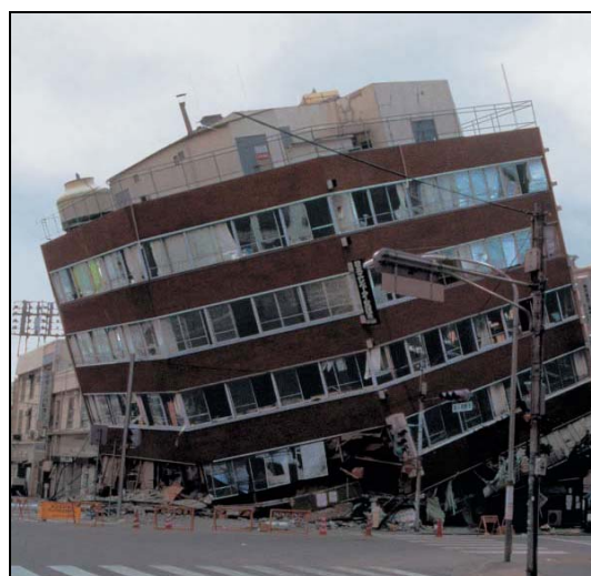
شکل ۳-۶- فاصله زیاد بین مرکز جرم و مرکز سختی و خرابی ناشی از ایجاد پیشچی
