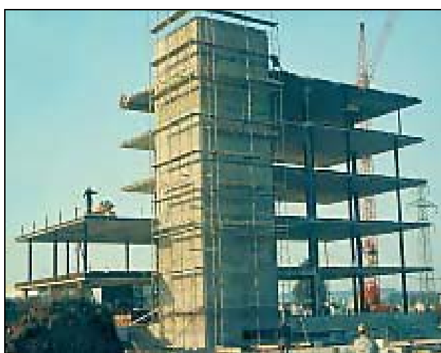
شکل ۳-۶- فاصله زیاد بین مرکز جرم و مرکز سختی و خرابی ناشی از ایجاد پیشچی
