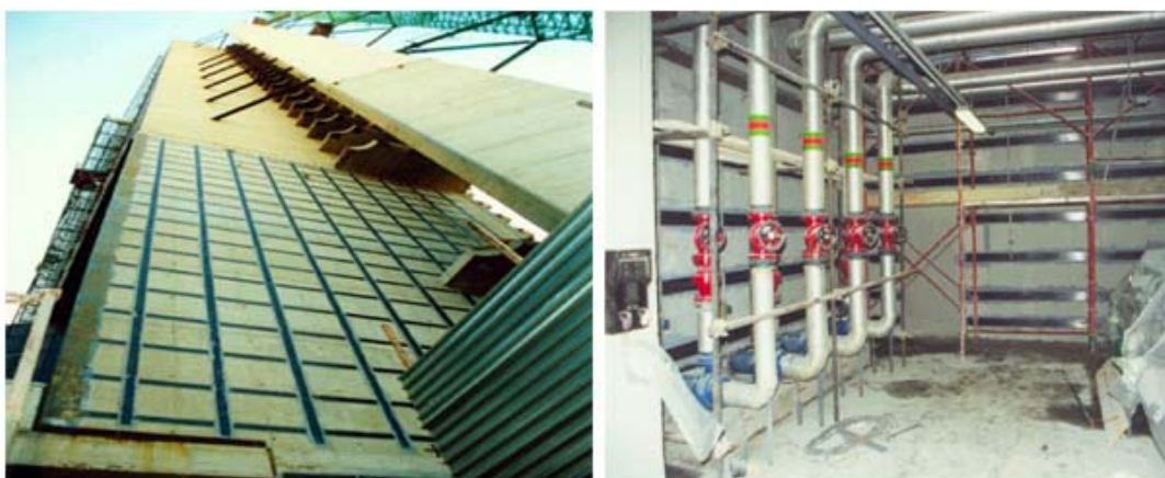
شکل ۴-۴۱- تقویت دیوار برشی با سیستم FRP
