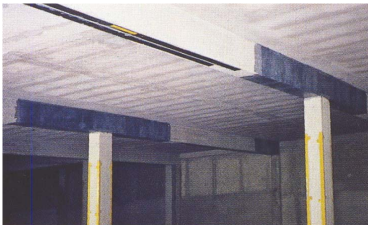
شکل ۲-۴-۸- کاربرد مصالح FRP در مقاوم‌سازی
