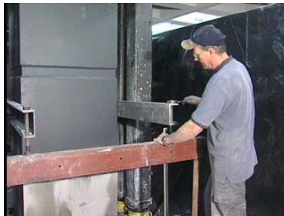
شکل ۶-۱۸ - نصب سازه خرپایی نگهدارنده
