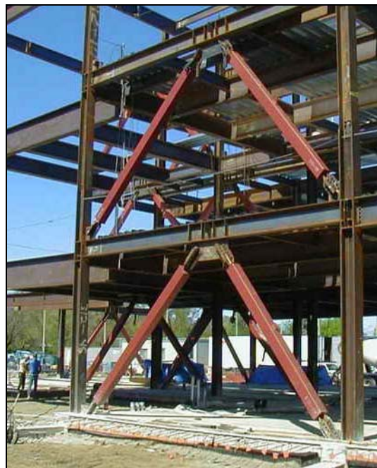
شکل ۴-۱۹- نمونه‌هایی از مه‌اربند ضد کمانش BRBF
