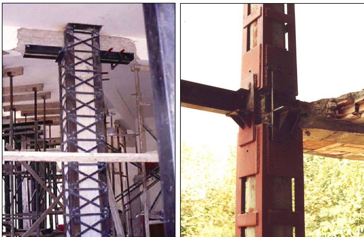
شکل ۲-۶-۲ روش‌های بهسازی اتصالات میانی
