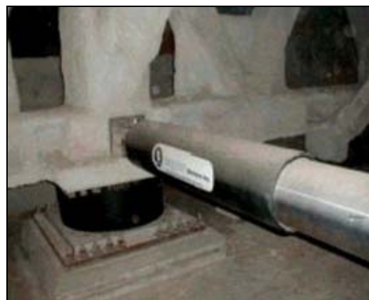
شکل ۷-۱۶- جزئیات تیپ سیستم میراگر ویسکوز
